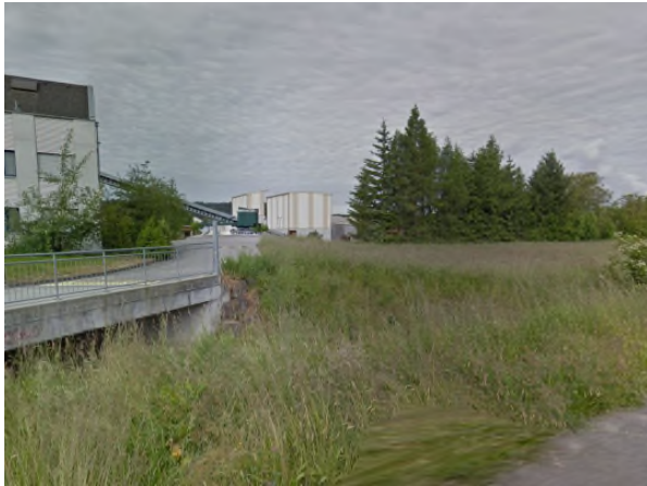
a) Blick auf Kies- und Betonwerk von Osten (Stausee- strasse)
